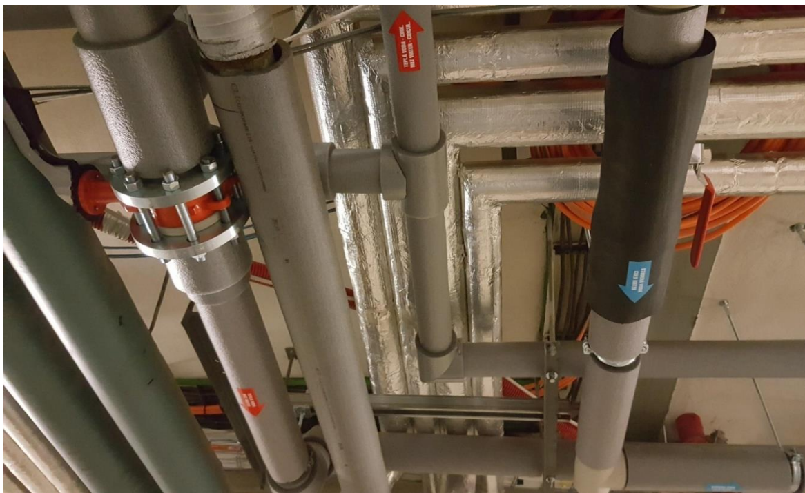
Kompletní oprava páteřních rozvodů ZTI
